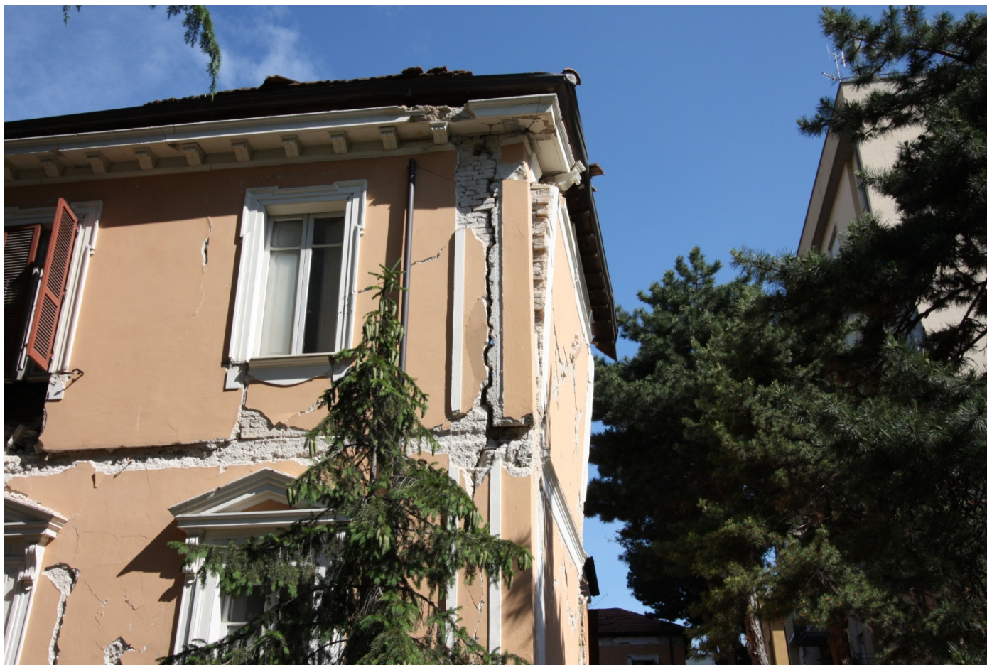
Ribaltamento fuori piano parete del piano superiore – L'Aquila 2009
